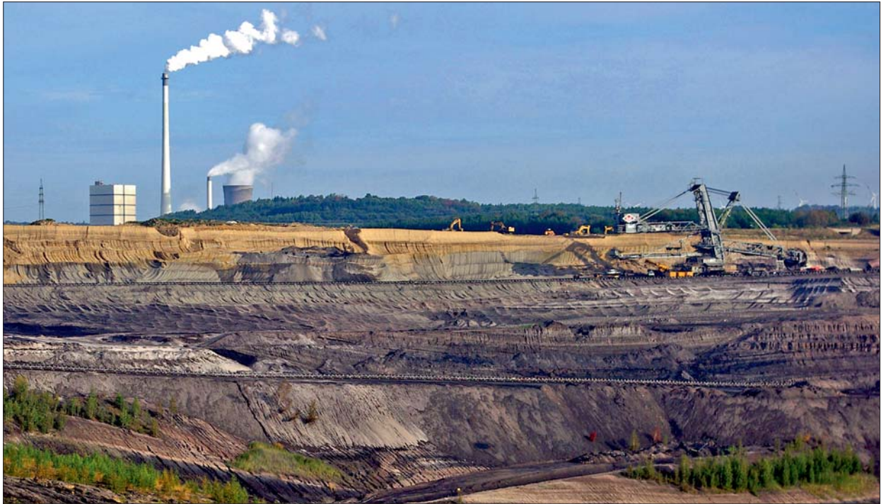
Abb. 3 Blick nach Norden auf den »Deutsche-Bahn-Pfeiler«. Im Hintergrund das Kohlekraftwerk Buschhaus. – Unter dem bereits abgetragenen Humushorizont erkennt man die Lössablagerungen der Weichsel-Eiszeit (Gelb bis hellbraun), Sand- und Geröllschichten der Saale-Eiszeit (hell- bis dunkelbraun), die organogenen Sedimente von Schöningen 12 II – Plateau 6, in denen die archäologischen Funde eingebettet sind (grau bis schwarz), Sande (hellbraun) und Grundmoräne der Elster-Eiszeit (grau), Sande (weiß) und Braunkohlenflöze (dunkelblau) aus dem Tertiär. – (Foto J. Serangeli).
