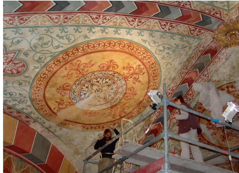
3 Stiftskirche zu Königslutter, während der Restaurierung des Vierungsgewölbes, 2006.
