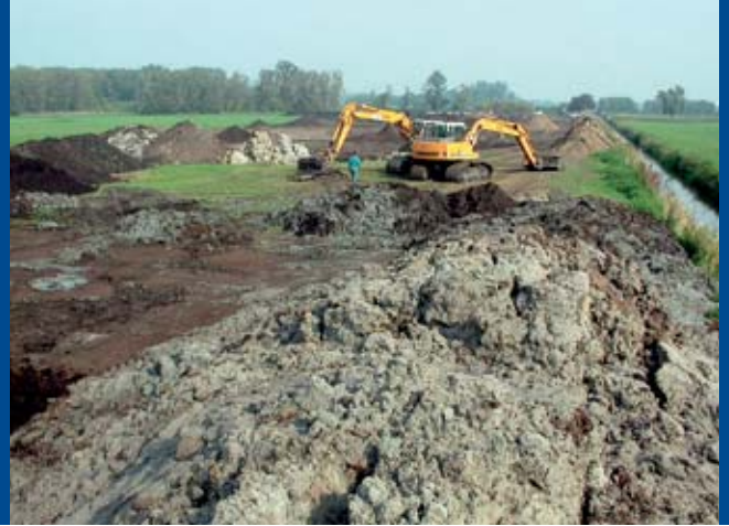
Ein neuer Flusslauf entsteht! Schwere Baumaschinen im Einsatz auf ökologisch und archäologisch wertvollen Flächen.
