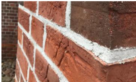
Instandsetzung mit tubag Gipsmörtel
