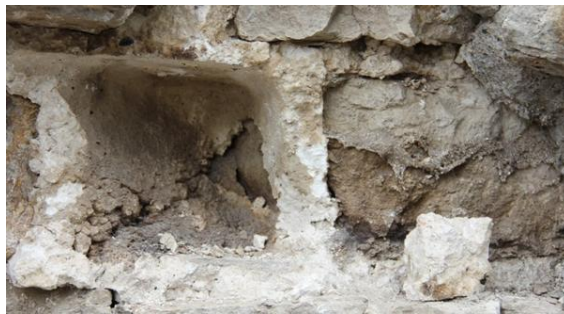
Mauerwerk mit historischem Gipsmörtel
